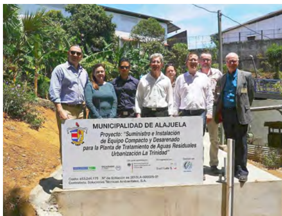
Planta de tratamiento de agua potable, “La Trinidad”, Alajuela Adquisición e instalación de equipos de depuración del agua Foto: Lahr, 2017
