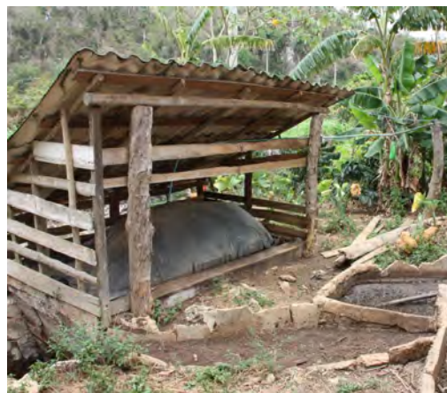
Biodigestor domiciliario en el campo, Cuba Foto: Susanne Bollinger [CC BY - SA 4.0]
