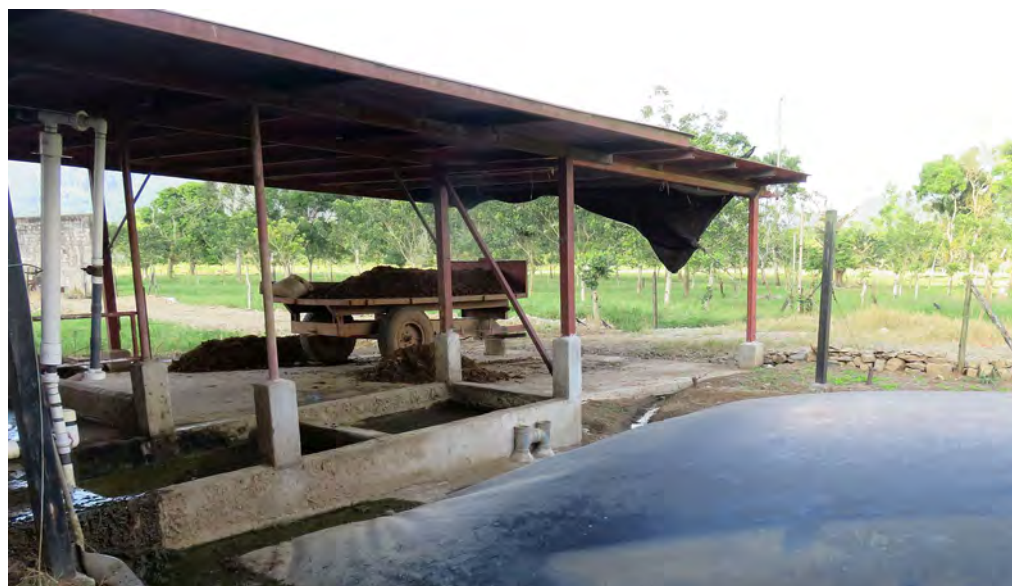
Biodigestor de laguna cubierta en finca lechera, Costa Rica
